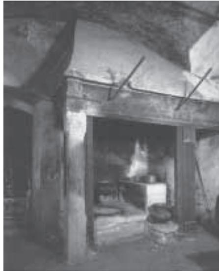
Abb. 12: Worb, Schloss, Küche, Kamin von 1536 mit Feuertisch und «Potager». Der Holzpfosten rechts als Stütze des geborsenen Sturzes nachträglich eingefügt (Bereich D).
