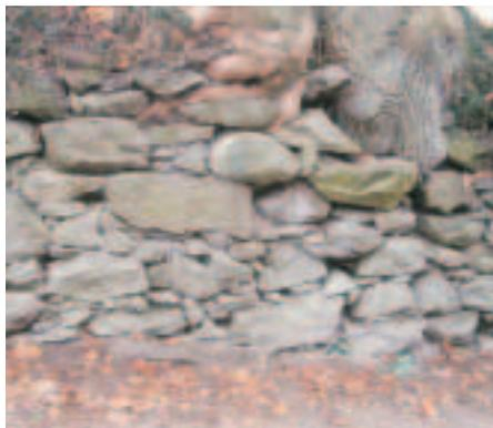
Abb. 16: Die talseitige Stützmauer im oberen Abschnitt des Schlossstaldens ist zum überwiegenden Teil aus Findlingsbruchstücken aufgebaut. Bei den meisten davon handelt es sich um Aaregranit aus dem Grimselgebiet.
