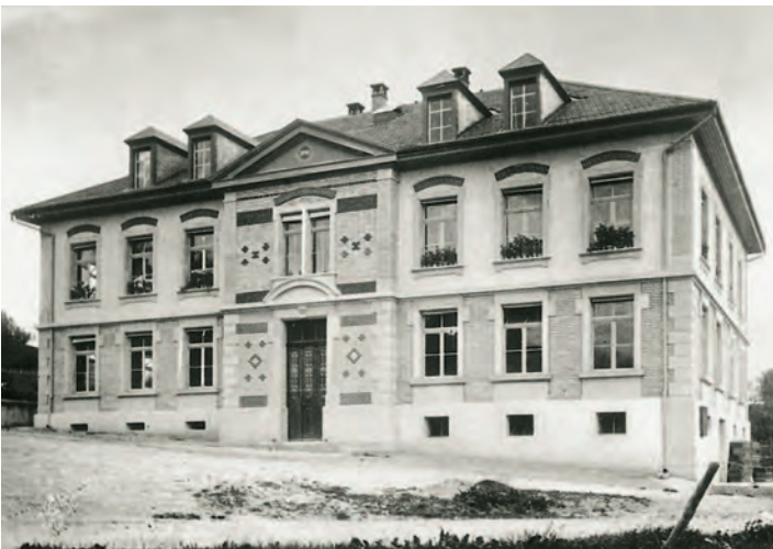
Das Schulhaus Oberbalm von 1898/99 ist ein typisches Landschulhaus des 19. Jahrhunderts. Der Backsteindekor und die Dachlukarnen über der Hauptfassade sind heute verschwunden. – Foto um 1900, Ernst Selhofer.
