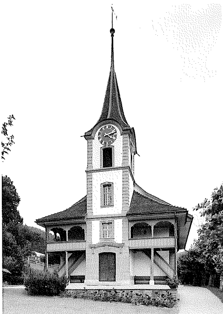
Abb. 233: Ludwig Emanuel Zehender, als Werkmeister auf dem Land vor allem für zahlreiche Neu- und Umbauten von Pfarrhäusern bekannt, schuf mit der Kirche Krauchthal ein kleines Meisterwerk, das den barocken Kirchenbau mit Einturmfassade und dreiseitig geschlossenem Saal geschickt der ländlichen Baukultur anpasst.
